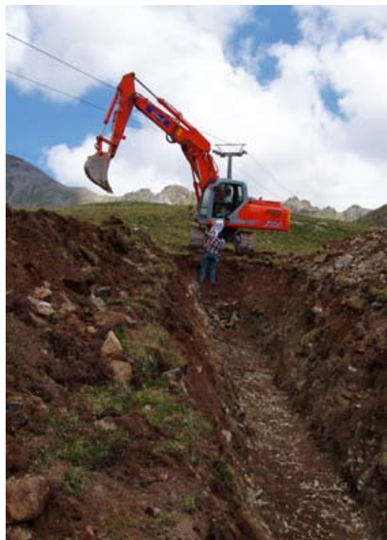
Erstellung einer Beschneiungsleitung in Suvretta / St. Moritz
