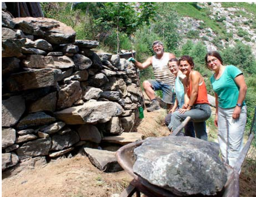
Projekt 1 – Wiederaufbau der hohen Stützmauer
