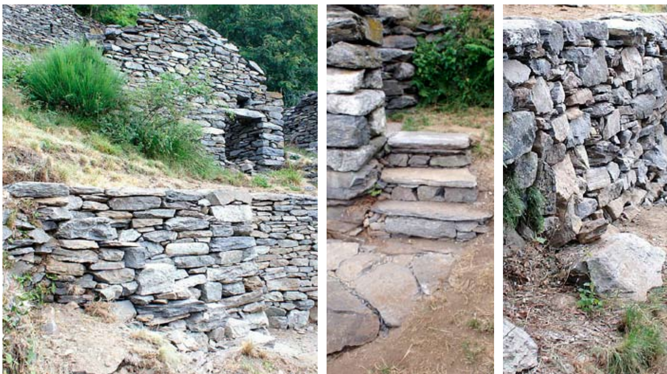
Wiederaufbau einer hohen Stützmauer mit Ecke und angebauter Treppe (Projekt 1; links), einige Stufen eines Treppenweges mit hangseitigem Mäuerchen (Projekt 2; mitte) und eine Stützmauer mit frei ausladenden Treppenstufen (Projekt 3; rechts)
